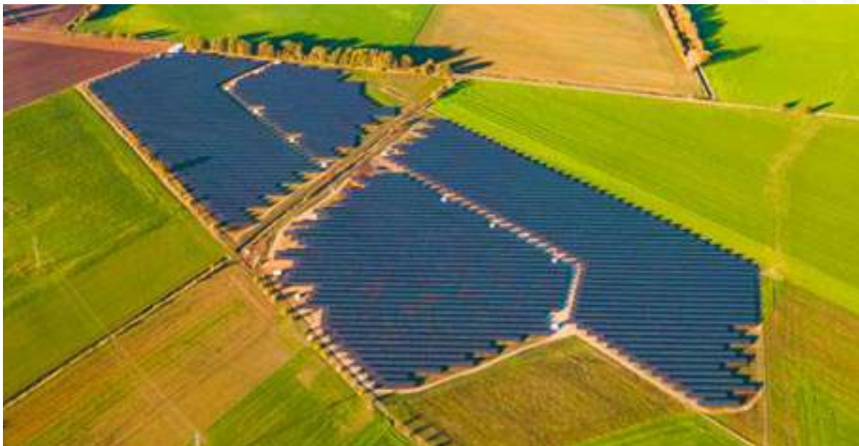
21.14 MW PV power plant, Bad Liebenwerda, Brandenburg, Deutschland.
